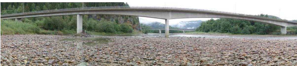
Figur 5: Eksisterende bru over Gaula. I bakgrunnen sees fv. 632 Folstad bru. Kilde: Norconsult.
